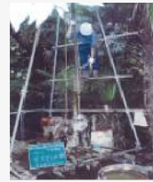
ボーリング調査
