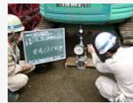
現場CBR試験
